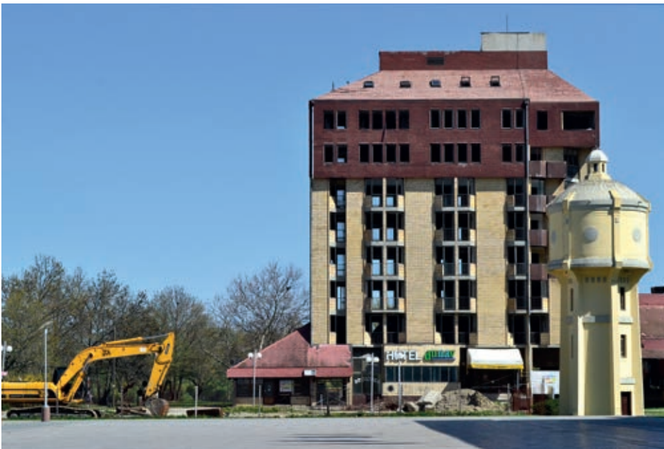
Der Stadtkern mit dem verlassenen Hotel Dunav ist noch immer eine Baustelle.
