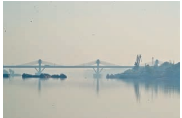
Die „Donaubrücke 2“ wurde 2013 fertiggestellt und ist eine von zwei Brücken auf der über 450 Kilometer langen Donaugrenze zwischen Rumänien und Bulgarien.
